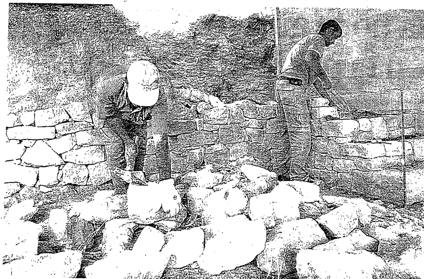
Operaris de Gbg aixecant una construcció de pedra seca, sense ciment, una tècnica que no és fàcil
