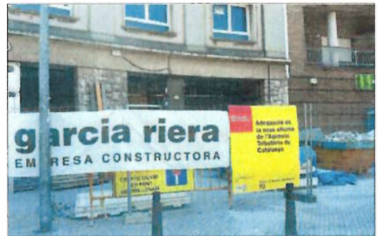
Imatge de les obres de la nova seu de l'ATC a Tortosa.
