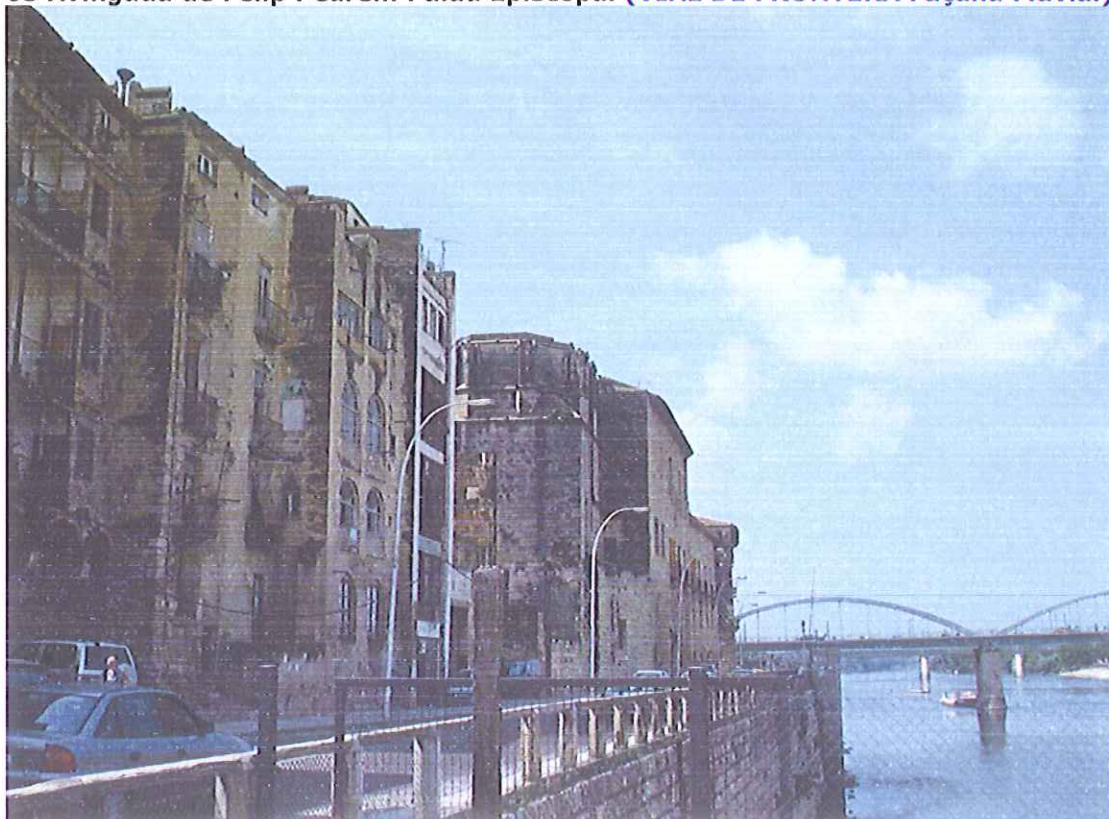
04 Avinguda de Felip Pedrell (VIAL DE FRONTERA Façana Fluvial)
