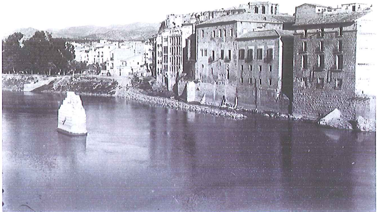
Façana fluvial (marge esquerra) amb l'antiga piona central del Pont de Barques en primer terme. Construcció dels murs del riu. Ca. 1920. Fons: Arxiu TLD, Tortosa.
