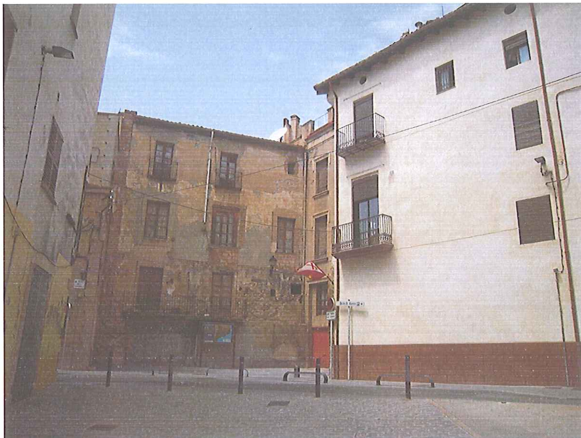
32 Carrer del Portal del Romeu
