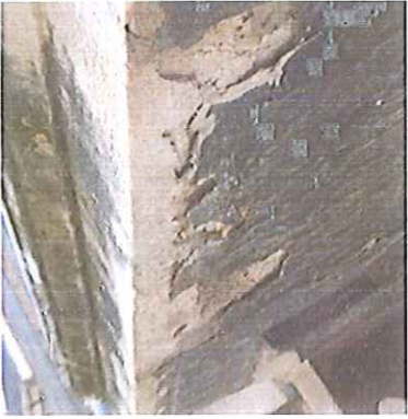
Alteració: Amb la contaminació torna a formar-se la crosta de guix.
