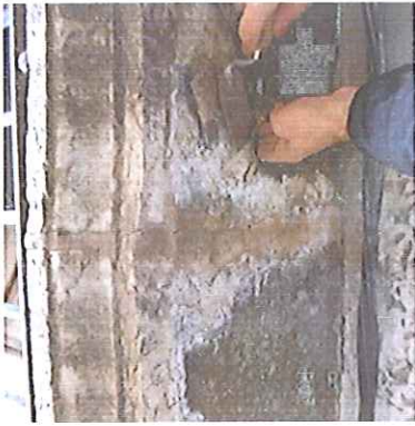
Alteració: En el seu procés d'envelliment apareix una crosta negra de guix.
